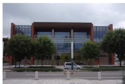
帯広信用金庫 中央支店 新築工事
