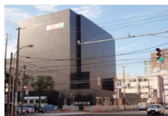
劇団四季 札幌劇場 新築工事
