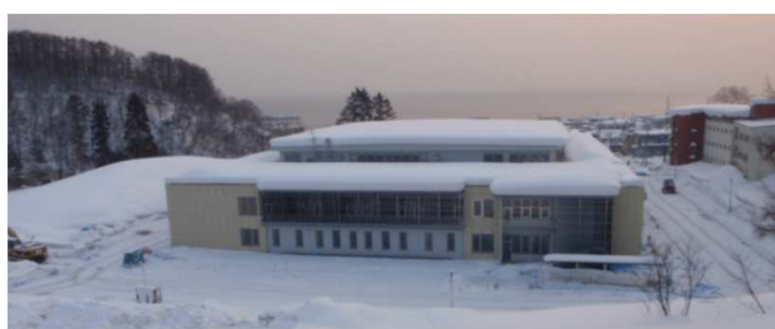
古平小学校 校舎・屋内体育館 新築工事
