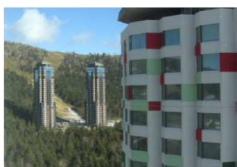
トナム・アルファーリゾート 改修工事
