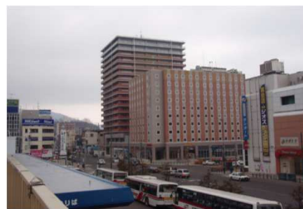
小樽駅前再開発 新築工事
