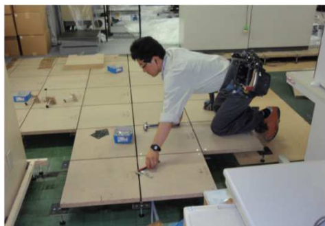
ニチロ畜産 大規模改造工事
