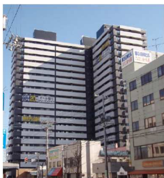
山の手開発プロジェクト 新築工事
