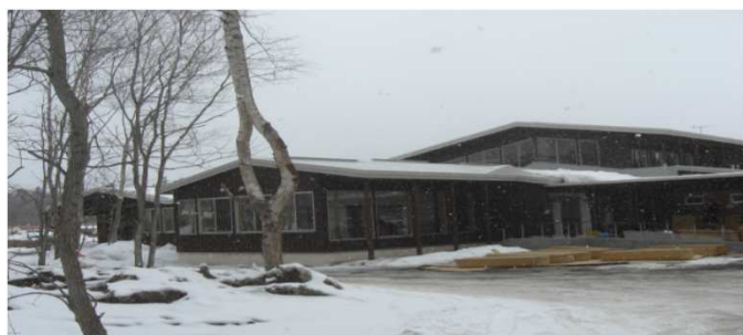
川湯の森病院 新築工事
