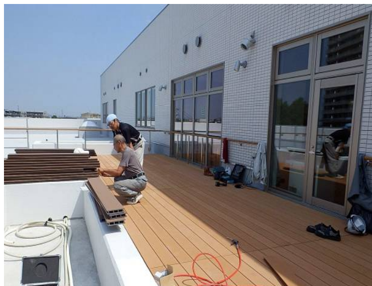
(ウッドデッキ 躯体側ほぼ完了)
