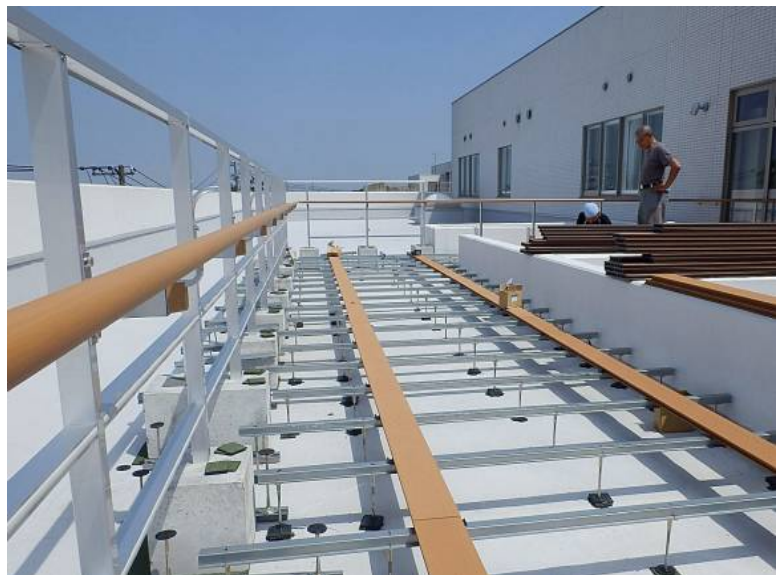
(ウッドデッキ 施工中)
