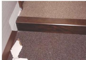
下枠と竿が接触して床鳴りが発生、竿を叩いて接触を止めます
