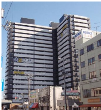
山の手開発プロジェクト 新築工事
