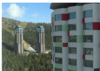
トマム・アルファリゾート 改修工事
