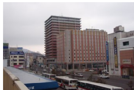
小樽駅前再開発 新築工事
