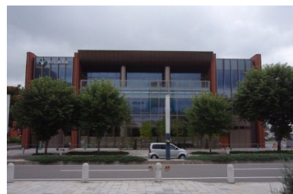
帯広信用金庫 中央支店 新築工事
