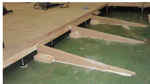
ニチロ畜産 大規模改造工事(スロープ制作中)
