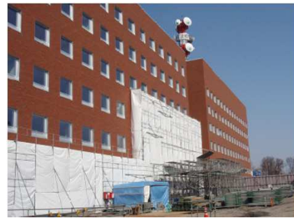
旭川合同庁舎 新築工事
