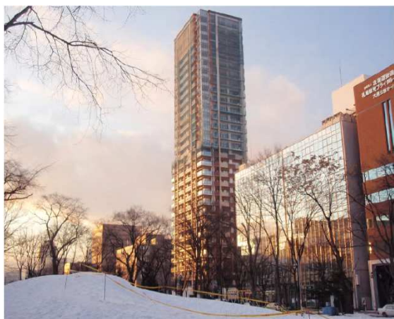
ザ・ライオンズタワー大通公園 新築工事
