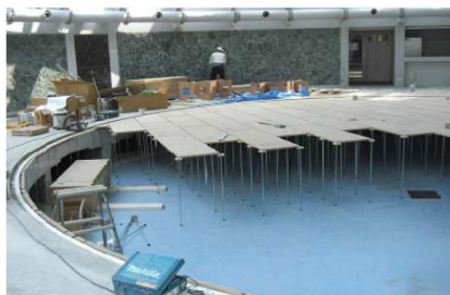
富良野プリンスホテル改修工事(プール棟)
