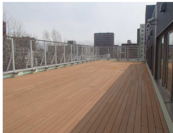
北9条小学校 テラス工事
