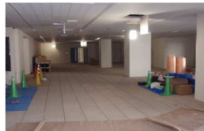
札幌刑務所 新築工事(事務室)OAフロアー
