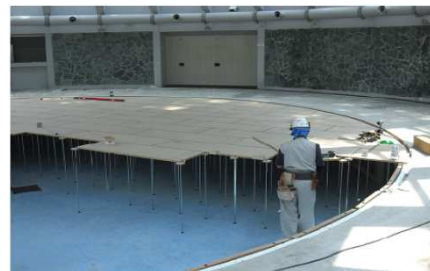
富良野プリンスホテル改修工事(プール棟)
