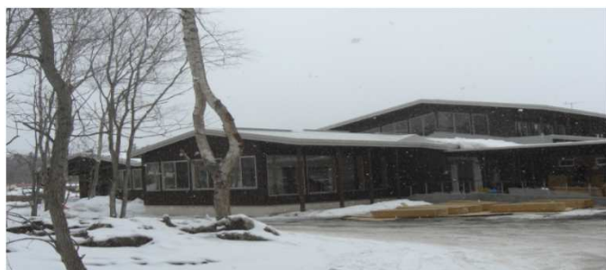
川湯の森病院 新築工事
