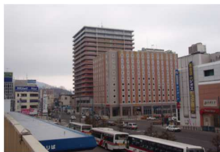
小樽駅前再開発 新築工事
