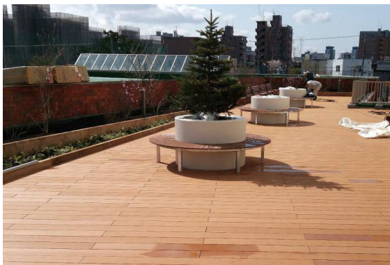
大友恵愛園 テラス工事
