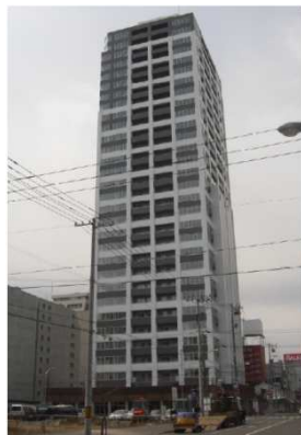
S3E3 新築工事(タワーレジデンス 高層30F)
