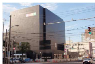
劇団四季 札幌劇場 新築工事
