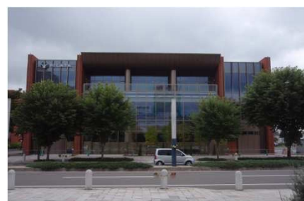
帯広信用金庫 中央支店 新築工事
