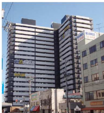
山の手開発プロジェクト 新築工事
