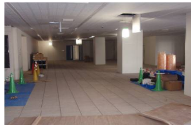
札幌刑務所 新築工事(事務室)OAフローア
