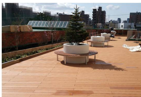
大友恵愛園 テラス工事
