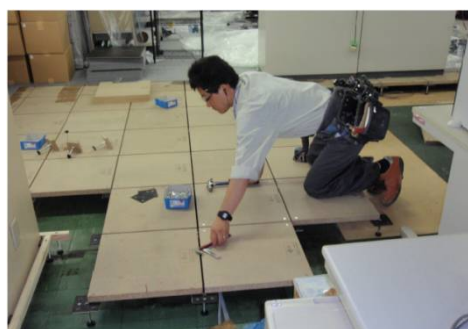
ニチロ畜産 大規模改造工事
