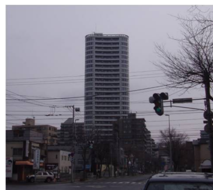
シティタワー円山神宮鳥居前新築工事（高層 28F）
