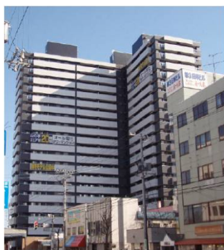
山の手開発プロジェクト 新築工事
