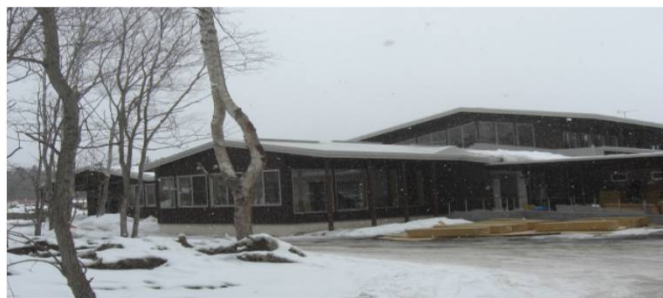
川湯の森病院 新築工事
