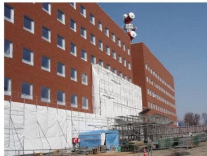
旭川合同庁舎 新築工事
