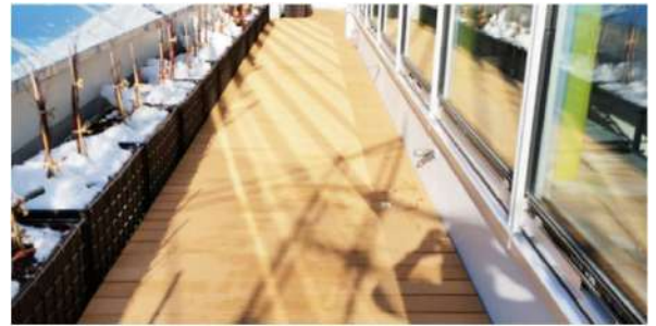
排水溝用の点検口を設置
