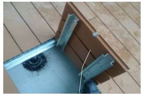
排水溝用の点検口を設置
