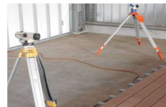
オートレベル 設置状況
