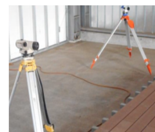
(オートレベル 設置状況)
