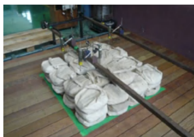
【共通：積載荷重試験】
