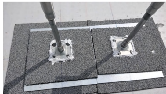
保護材t6 + 保護プレートt2.3 + 保護材t6 (バリキャップ) (ZAM鋼) (バリキャップ)
