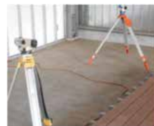
(オートレベル 設置状況)
