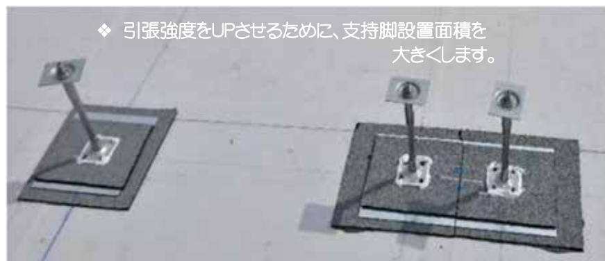
保護材t6 + 保護プレートt2.3 + 保護材t6 (バルキヤップ) (ZAM鋼) (バルキヤップ)
