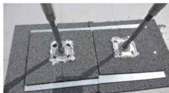
保護材t6 + 保護プレートt2.3 + 保護材t6 (バルキヤップ) (ZAM鋼) (バルキヤップ)
