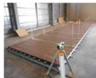
(はかり棒 設置状況)
